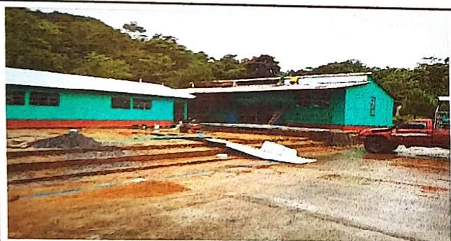
Foto 5: cambio de estructura de madera a metal, cambio de techo.
