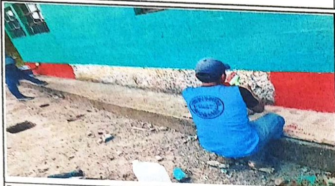
Foto1: cambio de estructura de madera a metal, cambio de Techo, pintadas paredes interior y exteriores, cambio de chaspa y pintada de puerta.
