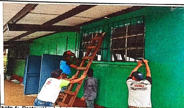
Foto 4: Restauración de balcones, pintadas de paredes y de puertas
